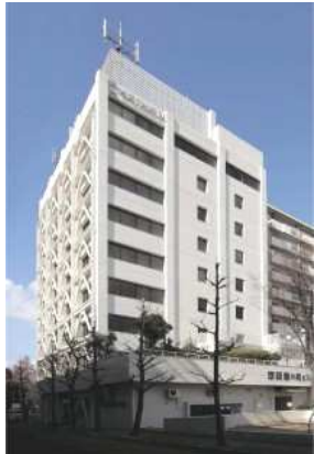
京阪藤森ビル外観
